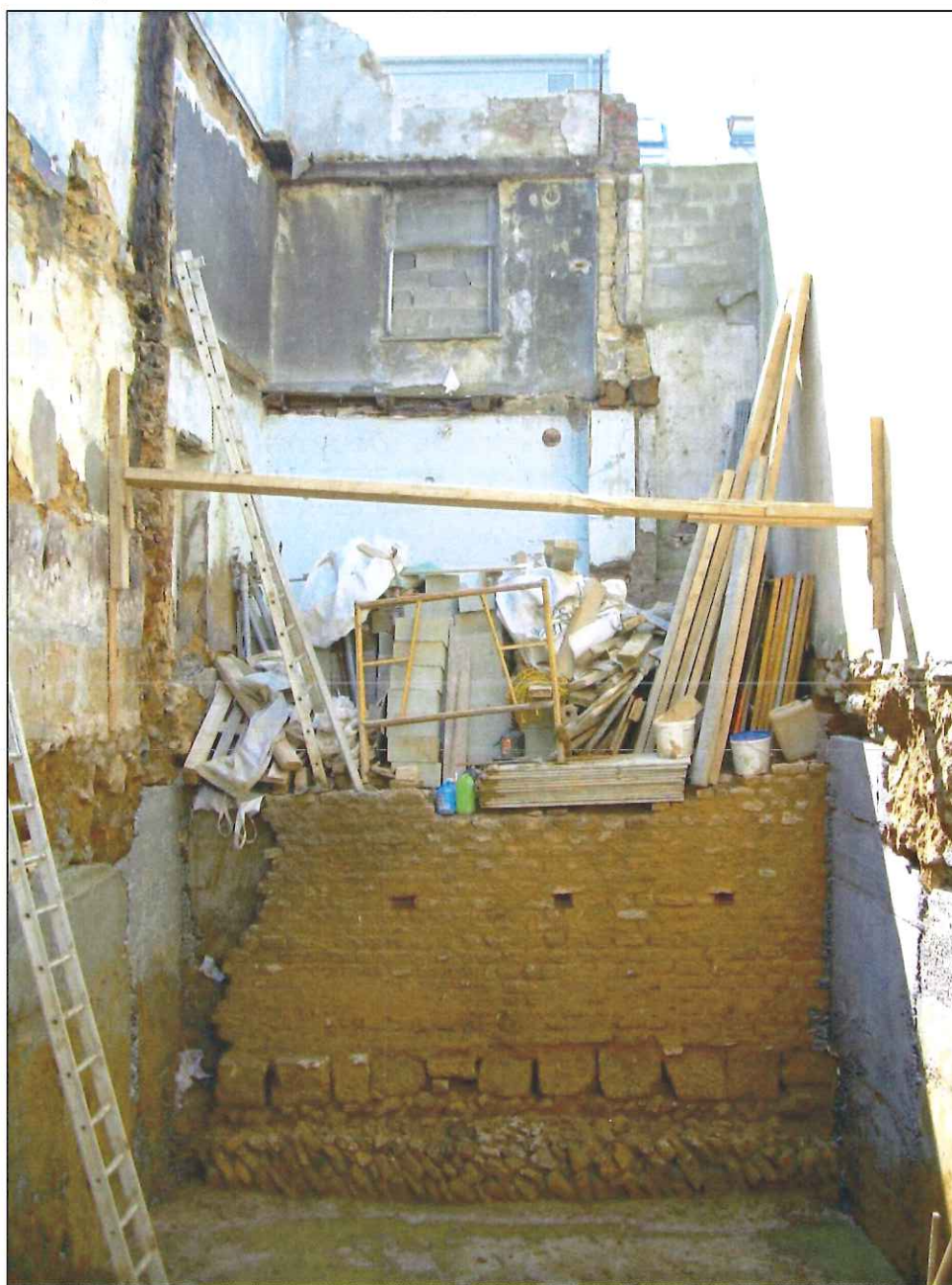
Fig. 1: Arlon, le rempart en cours de dégagement (© 2009 SPW D. Henrotay)
